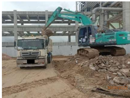
รูปที่ 3-36 ตัวอย่างรถขนย้ายเศษคอนกรีตไปรับถมในพื้นที่ลุ่มที่ได้รับอนุญาต
